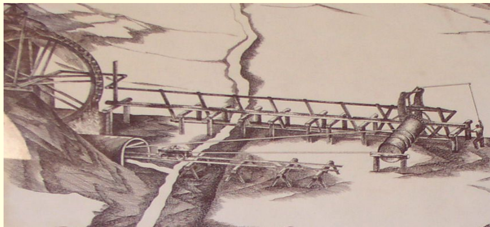
Лежневый путь и вагонетки, приводимые в движение от водяного колеса по проекту Козьмы Дмитриевича Фролова, Алтай, 1783 г..
