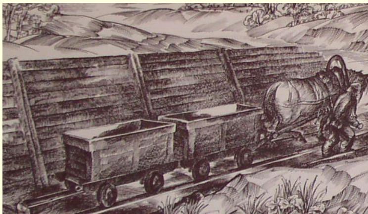
Выемка Змеиногорской чугунной дороги.
