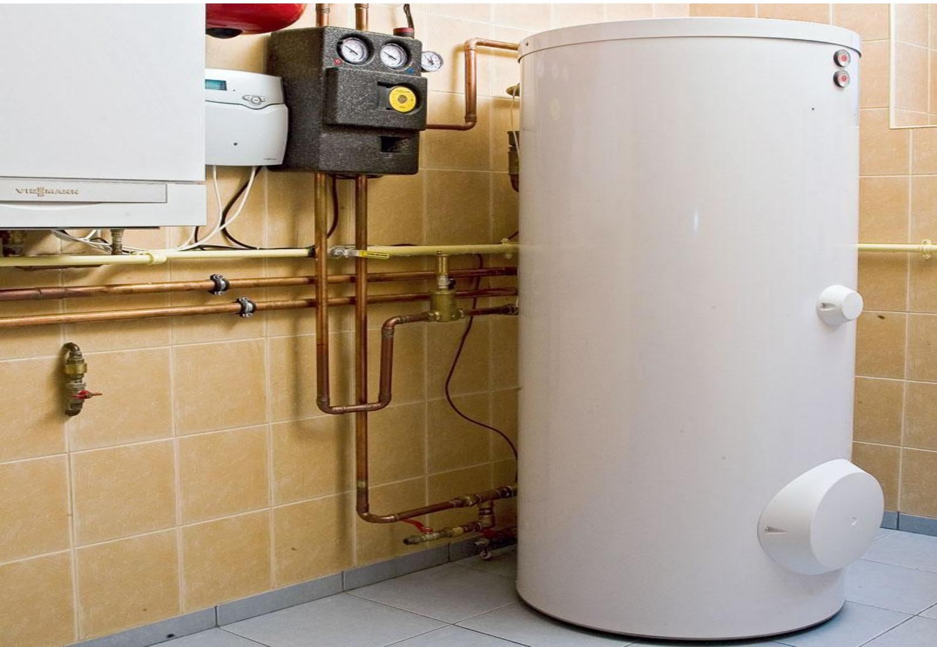
**Трубопровод** - совокупность деталей и сборочных единиц из труб с элементами, являющимися их составляющими (тройники, переходы, отводы, арматура и др.), которые предназначены для транспортировки пара или горячей воды от источника (котел, турбина, насос, бойлер, ТЭЦ, котельная и т.д.) до потребителей: турбина, подогреватель, система отопления и т.д.
