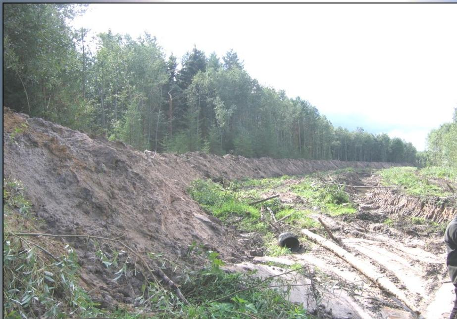
Отремонтированы и вновь созданы дамбы обвалования береговых гидроотвалов, объем работ 303 тыс. м<sup>3</sup>, заменено 4400 метров рефулерных труб.
