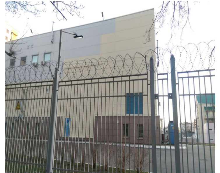
Ограждение из сварной решетки
