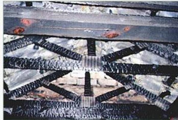
Деревянные конструкции продолжают ↑ удерживать кровлю от обрушения
