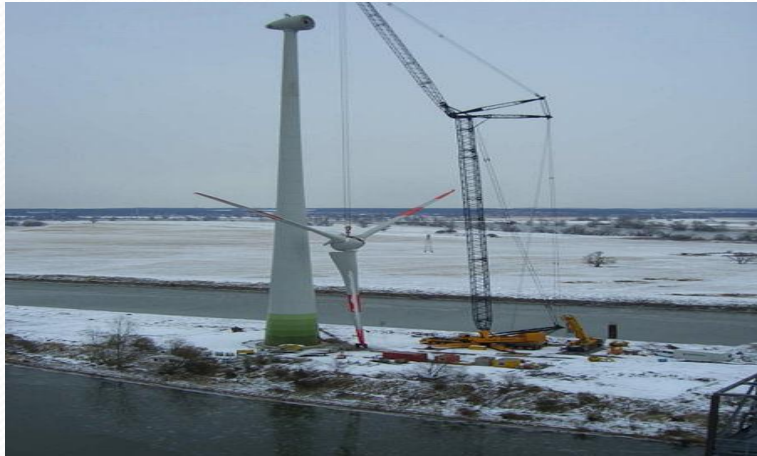
Строительство ветряной турбины в Германии.
