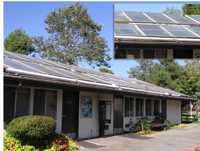
Прачечная, использующая для работы солнечную энергию
