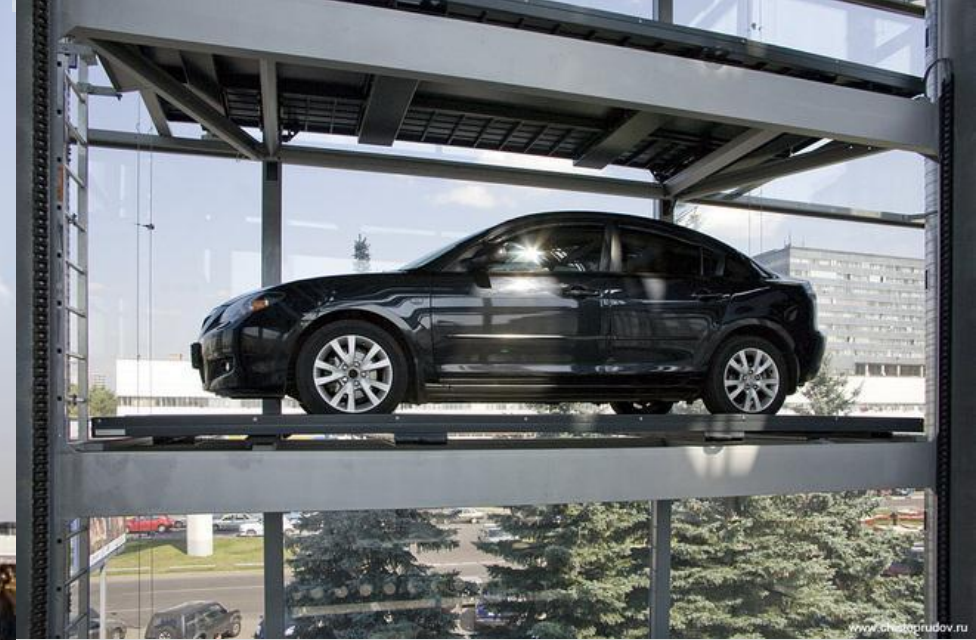
Рис. 5.1. Многоэтажный автомобильный паркинг, г. Москва
