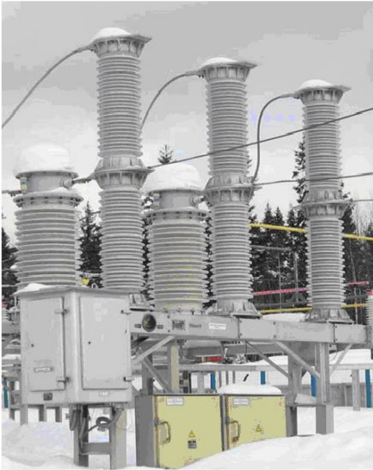
Елегазовий вимикач ВГТ -110II-40/2500(110кВ ).
