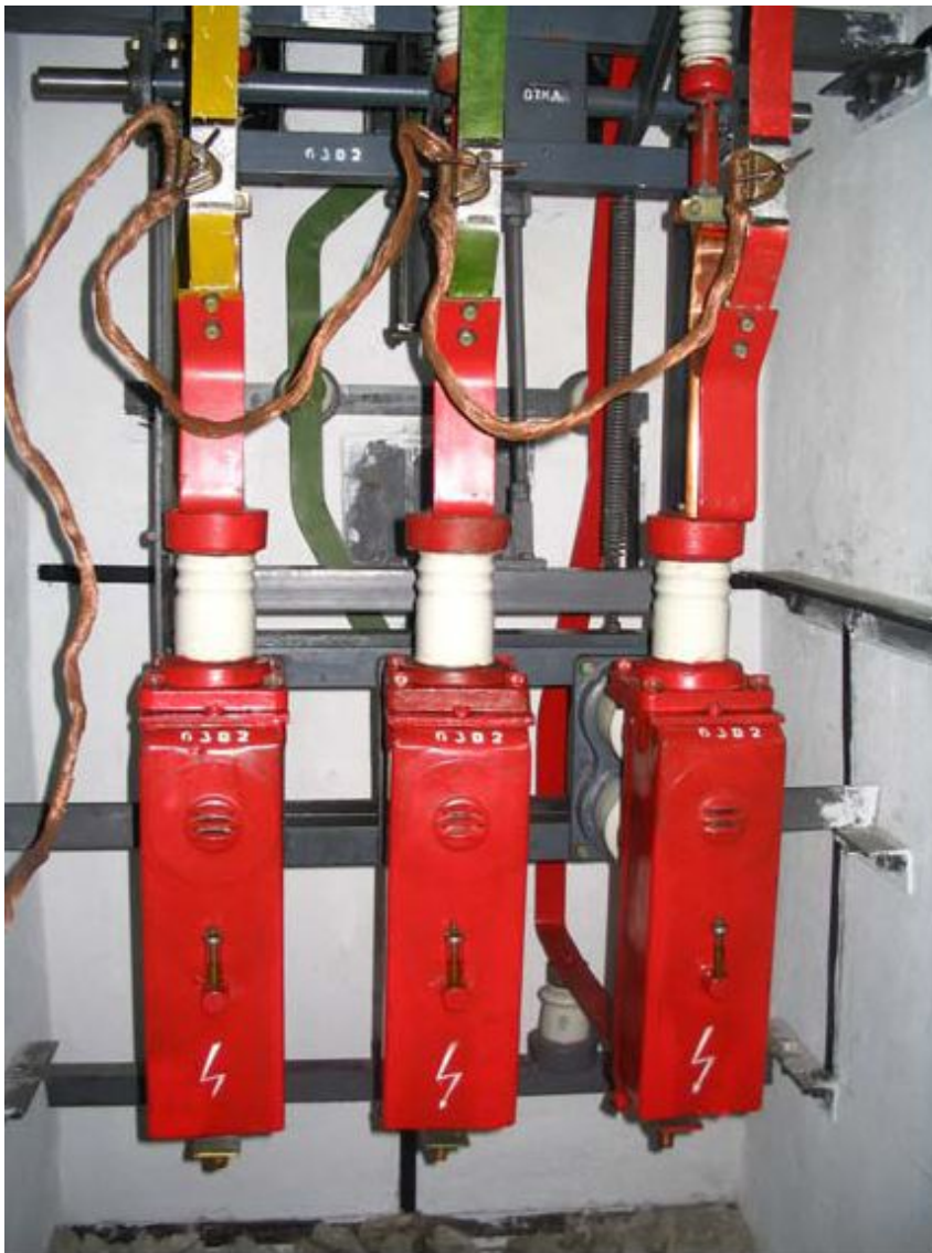
Вимикач стаціонарний типу ВМГ-133
