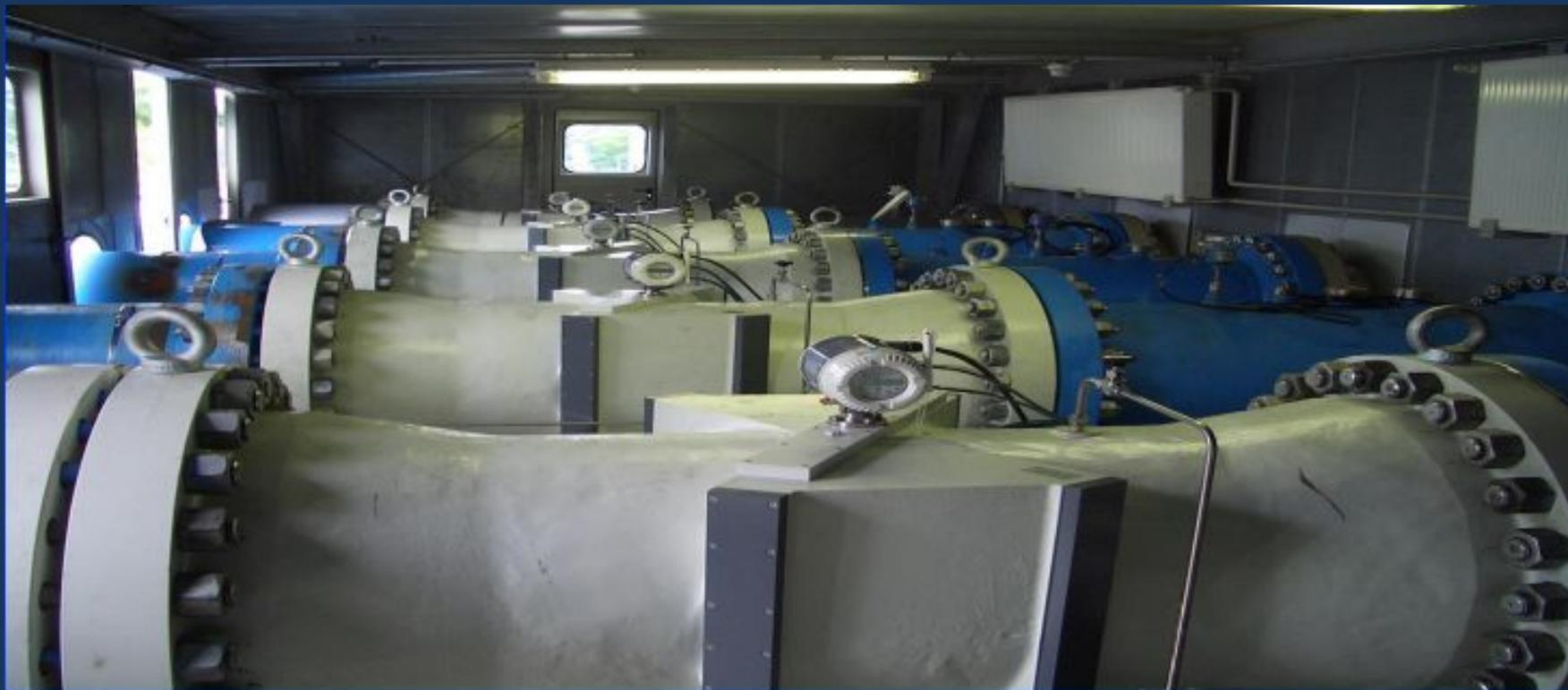
Основная область применения прибора – коммерческий и технологический учет сухих, влажных, коррозионных и абразивных газов в процессе их производства, хранения, транспортировке.
