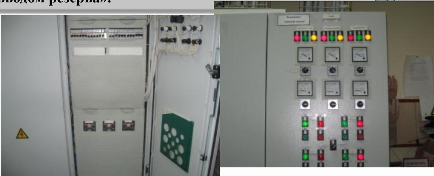
**Для обеспечения непрерывного питания устройств связи, применяются источники бесперебойного питания, обеспечивающие питание во время переключения стойки АВР между основным, резервным вводом или ДГА**
