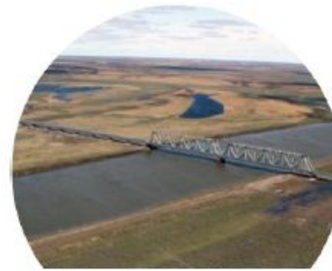
МОСТ ЧЕРЕЗ ЮРИБЕЙ (Ямало-Ненецкий АО, 2009)
