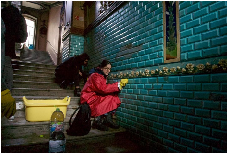
Краеведы и волонтеры из объединения ГЭНГЪ отмывают масляную краску от редкой настенной английской плитки в парадной доходного дома Бернштейна на 2-й Советской, 106
