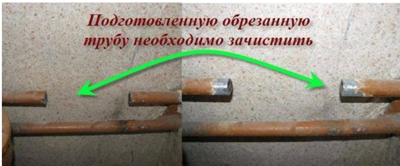
Обрезка и очистка труб
