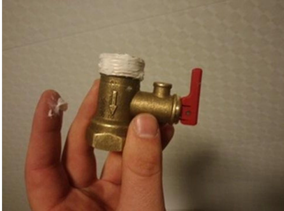
Герметизация резьбы
