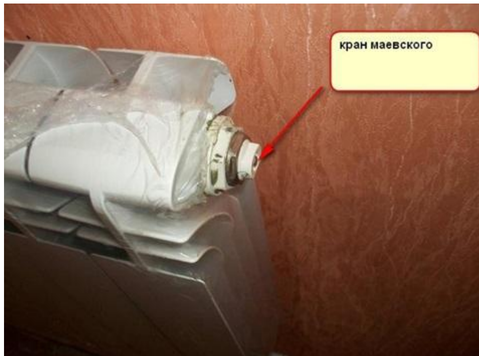
Устройство для удаления воздуха из системы отопления
