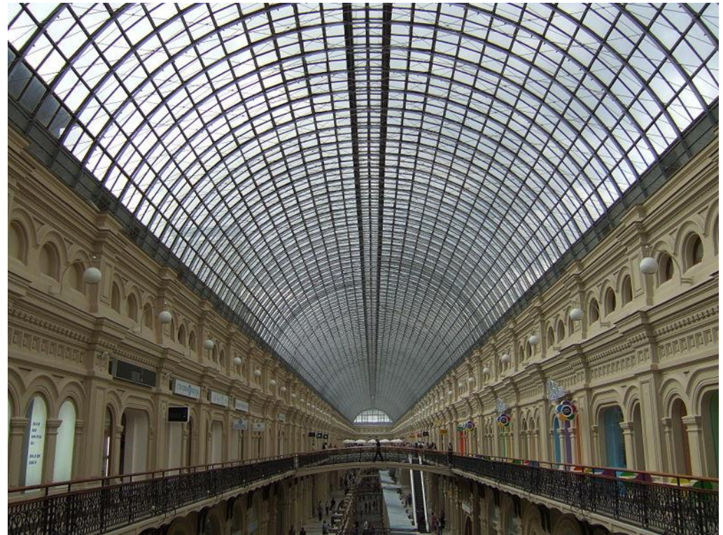
В.Г.Шухов. Конструкции арочных покрытий московских магазинов ГУМ
