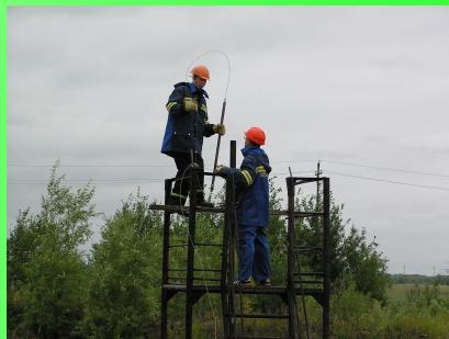
Производится отбор желонкой открытых ГП. По ним определяется интервал отбора закрытых проб, где обводненность продукции не более 10%.
