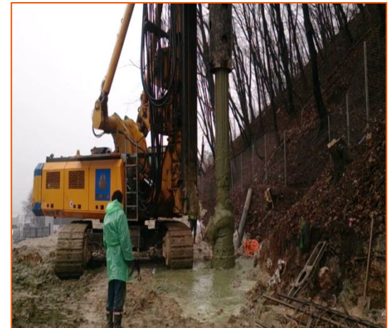
Фото 11. Технология устройства свай
