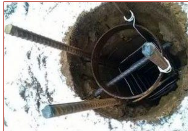
Фото 10. Каркас буроопускной сваи
