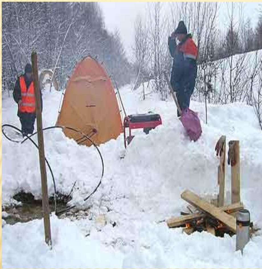
Прокладка и монтаж кабеля в мороз – недопустима!
