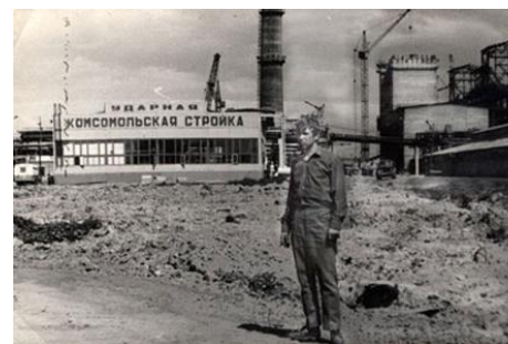
Новотульский металлургический завод,
