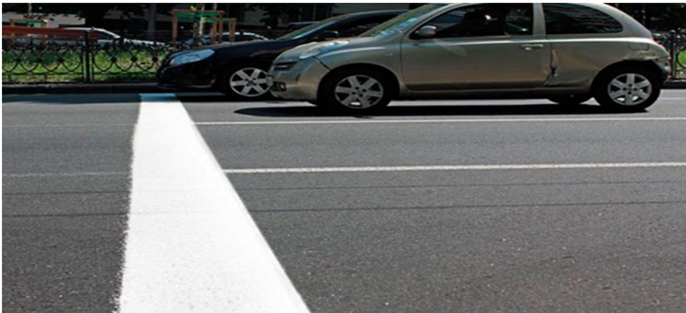
**Дорожная разметка 1.12 представляет собой широкую полосу белого цвета (40 см), нанесенную под прямым углом к оси полосы движения. Она указывает место, в котором водитель должен остановиться при запрещающем сигнале светофора (регулирущика) или наличии [знака 2.5 «Движение без остановки запрещено»](#).**
