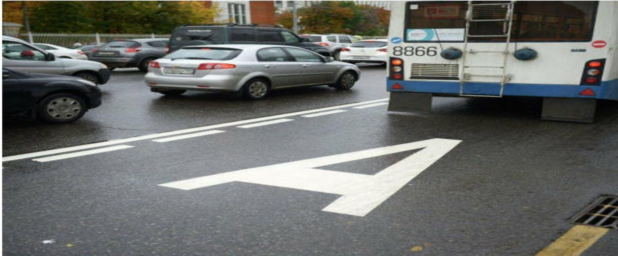
**Разметку 1.23.1 (букву А) наносят на дорогах, обозначенных знаком 5.11.1 «Дорога с полосой для маршрутных ТС», на полосы, которые предназначены для движения только маршрутных транспортных средств и такси. Разметку повторно наносят после мест остановок маршрутных ТС, и повторяют через определенное расстояние (примерно 200 м) на всем протяжении выделенной полосы.**
