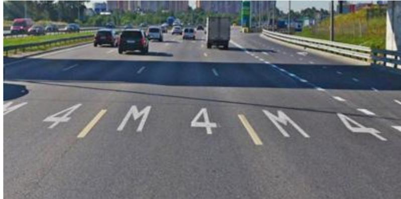
***Разметку номера дороги наносят посередине каждой полосы движения, соответствующей направлению дороги (маршрута). Ее также наносят перед перекрестком и за перекрестком, когда маршрут в месте пересечения с другой дорогой меняет свое направление.***
