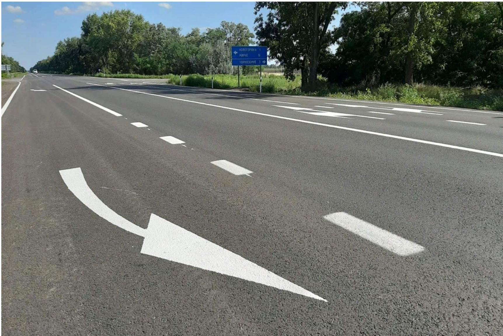
**Разметку 1.19 применяют для предупреждения о приближении к сужению проезжей части (к концу полосы). В сочетании с [разметкой 1.6](#) при ограниченной видимости встречного автомобиля она предупреждает приближении к разметке 1.1 или 1.11, разделяющей противоположные потоки ТС.**
