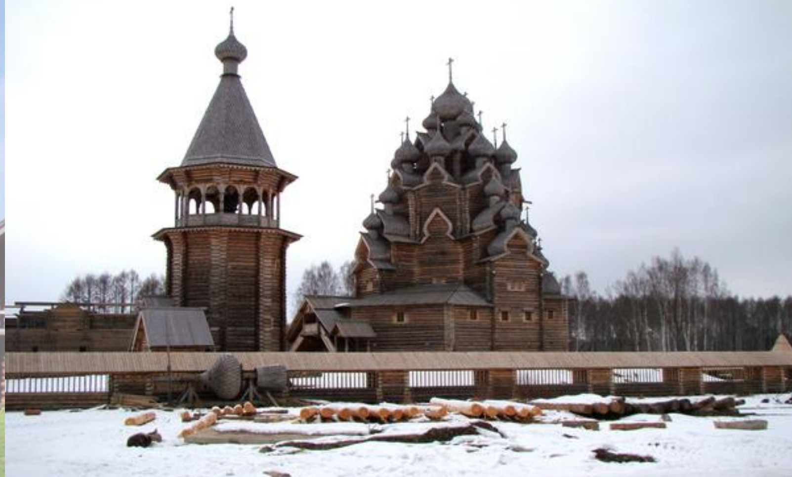
Покровская церковь 2008г. г.Санкт-Петербург Реконструкция сгоревшей Покровской церкви 1708г. из села Анхимово Вытегорского погоста 25 глав
