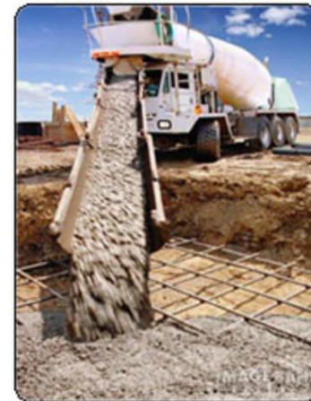
Рис. 10.7. Бетонная смесь: а – пластичная многокомпонентная полидисперсная система; б – прием бетонной смеси из миксера при изготовлении армированной фундаментной плиты
