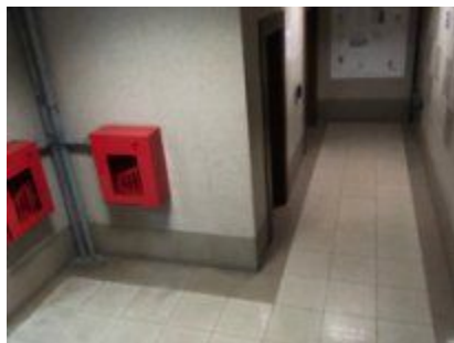
КАМ.6 позволяет просматривать лифтовой холл первого этажа 1 подъезда
