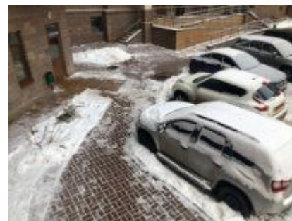
КАМ.4 позволяет просматривать входную группу и прилегающую территорию подъезда #3
