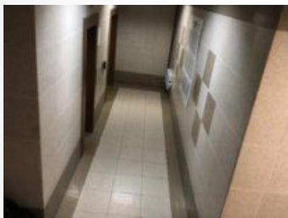
КАМ.8 позволяет просматривать лифтовой холл 1 этажа 2 подъезда
