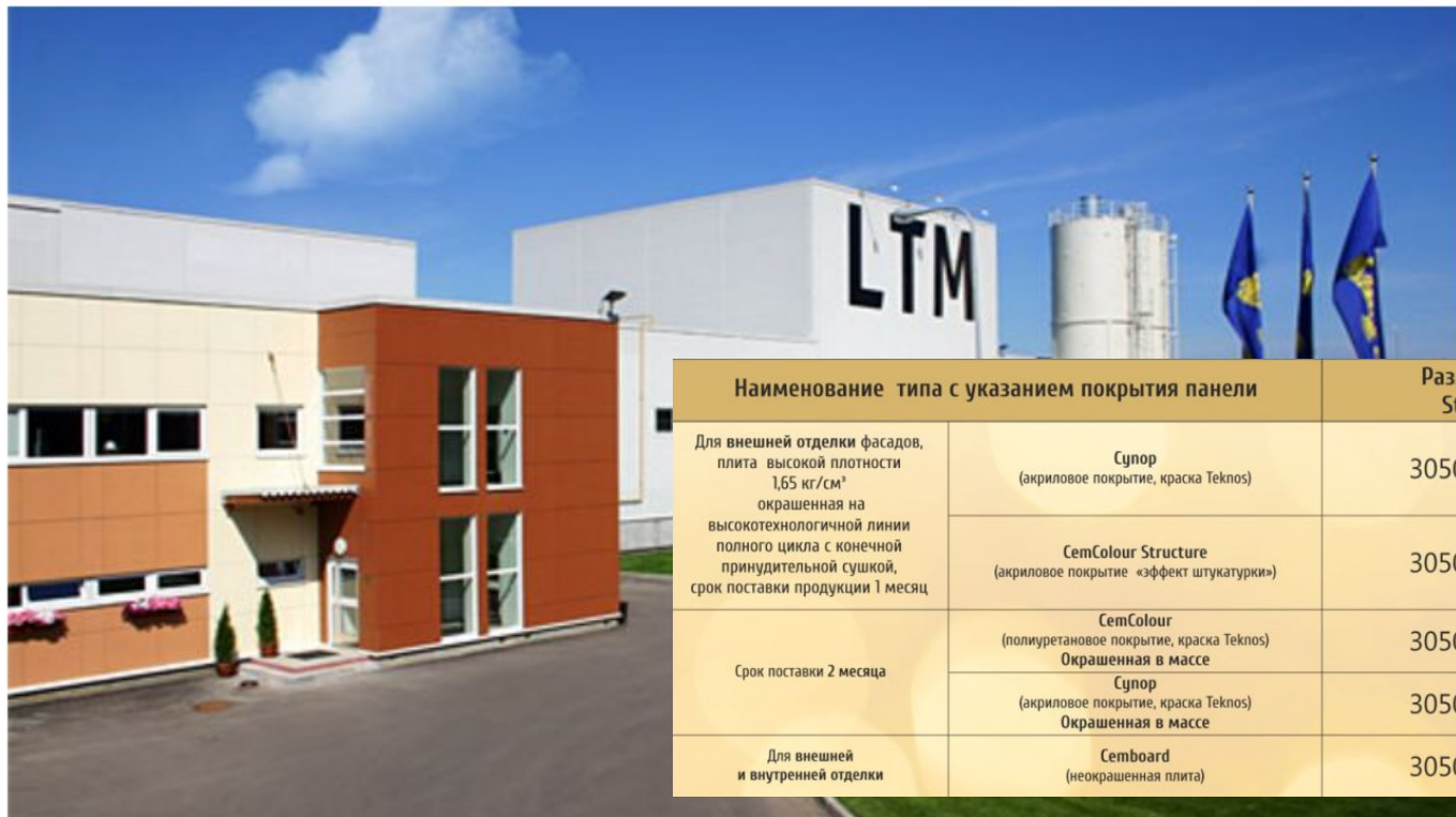
Производственное здание компании LTM в Обнинске
