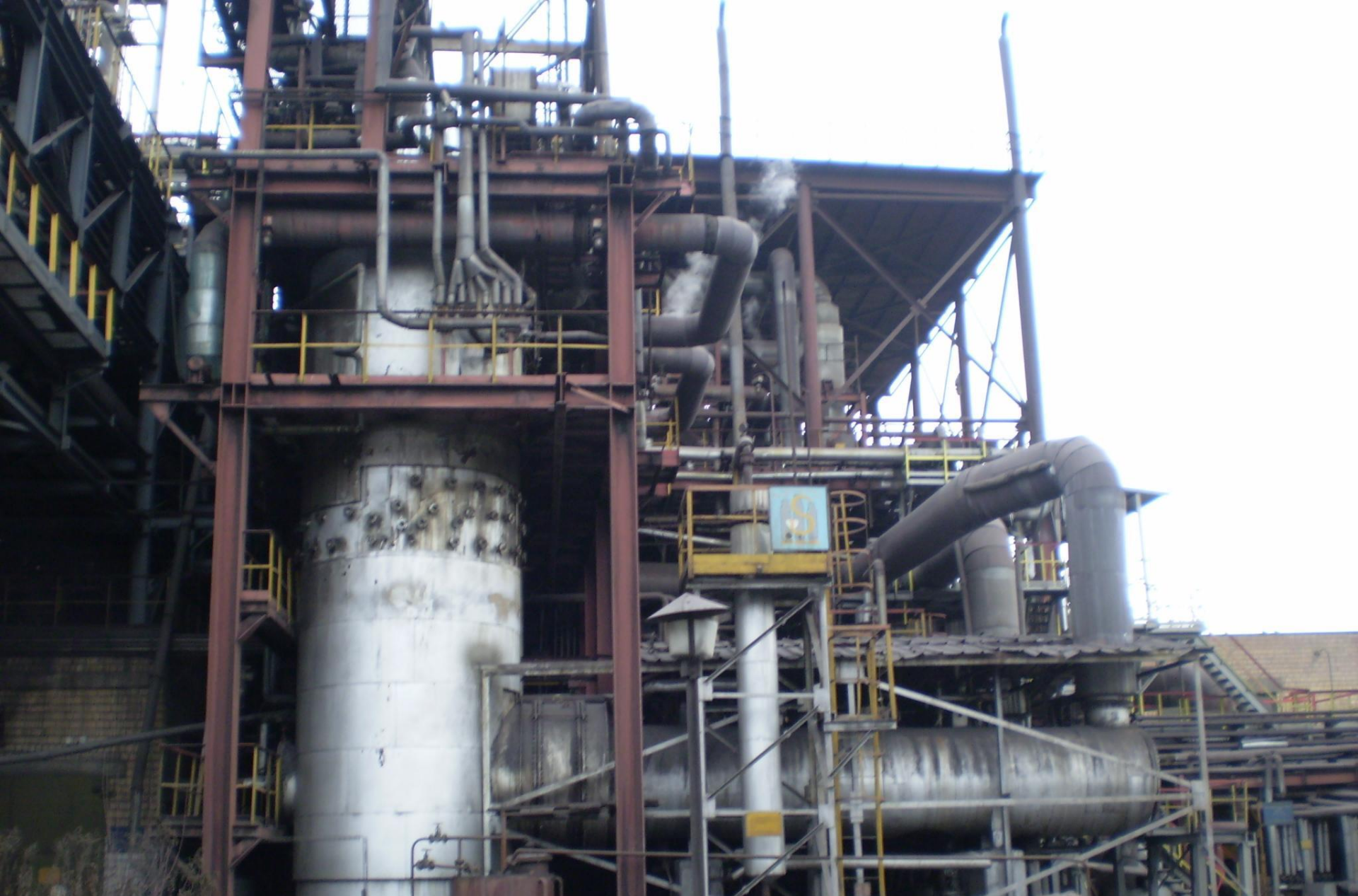
Участок выделения серы и разложения аммиака блока улавливания №2
