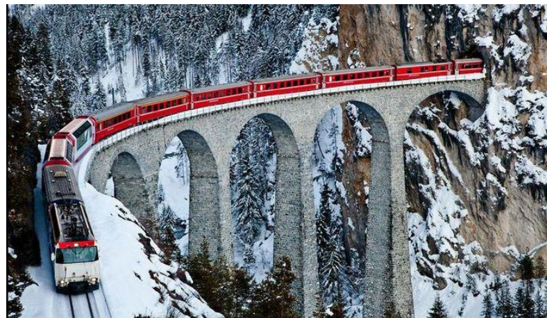
Швейцария железнодорожный мост h=65\text{м} и l=136\text{м}
