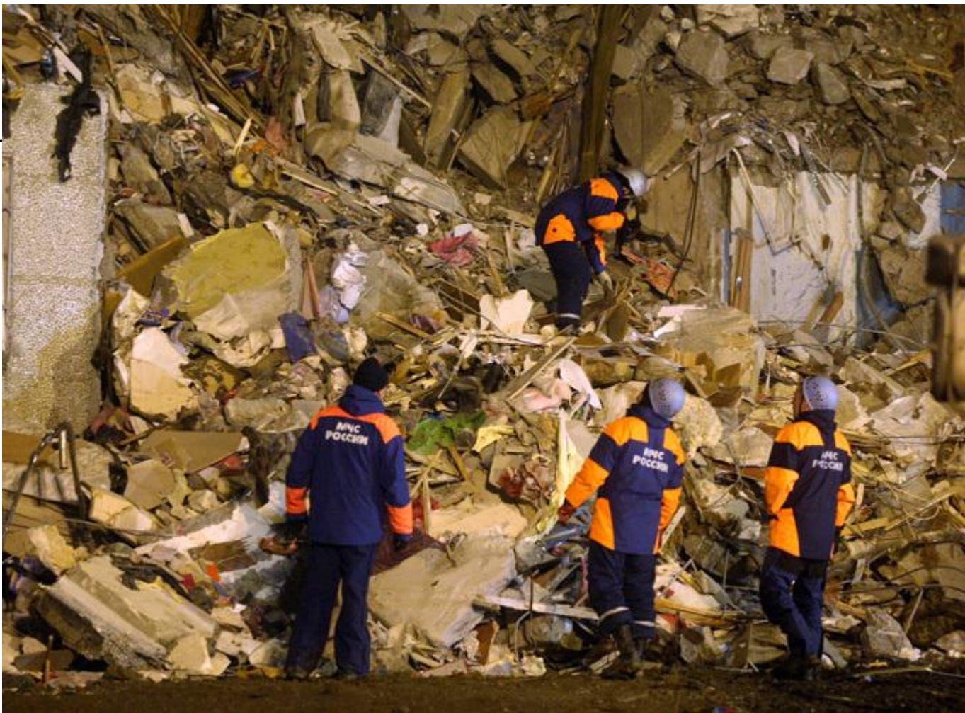
проведение спасательных работ
