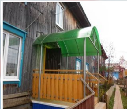
Ремонт подъездных крылец (ТОС «Берег»)
