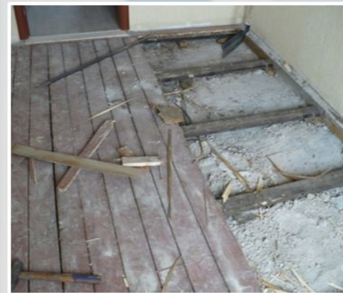
Ремонт утепленного входного тамбура, ремонт полов входной площадки (ТОС «Собственник»)
