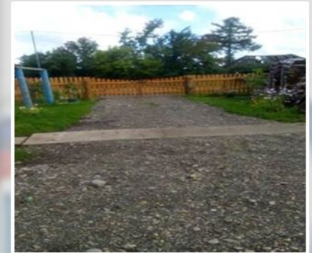
Ремонт и прокладка дорожно-тропиночной сети (ТОС «Родник»)
