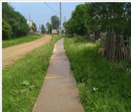
Прокладка дорожно-тропиночной сети (ТОС «Савинский»)
