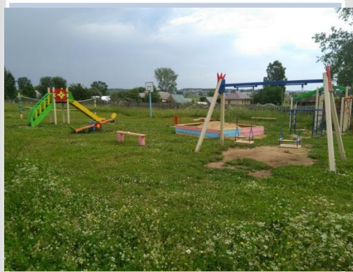
Строительство детской спортивной площадки (ТОС «Савинский»)
