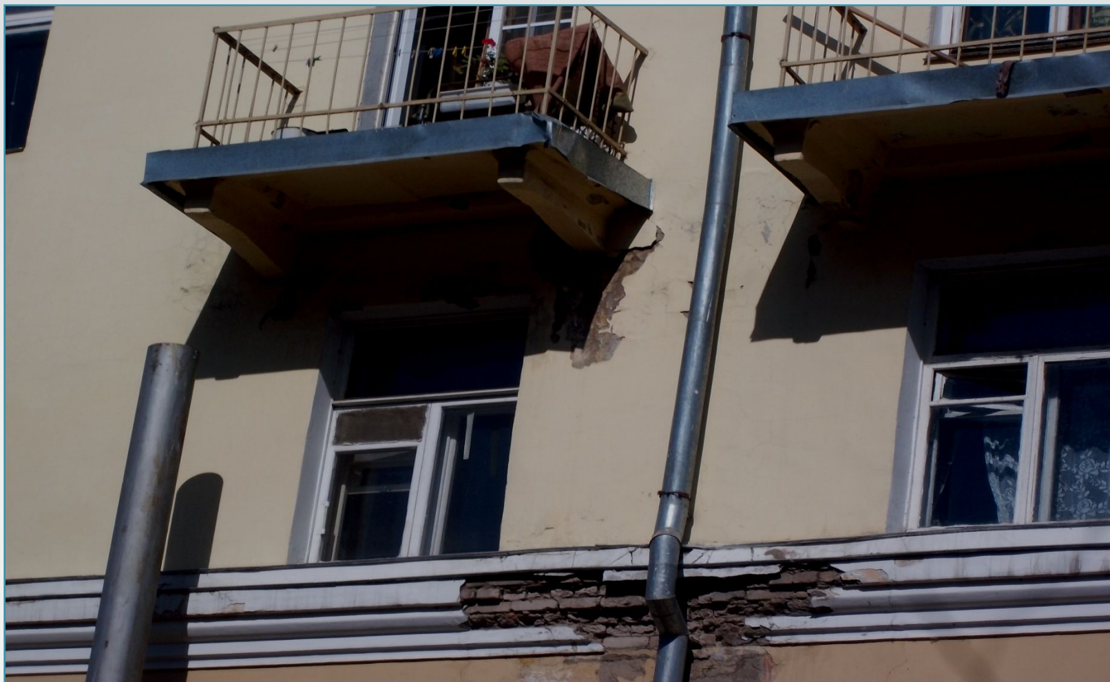
Разрушение фасада
