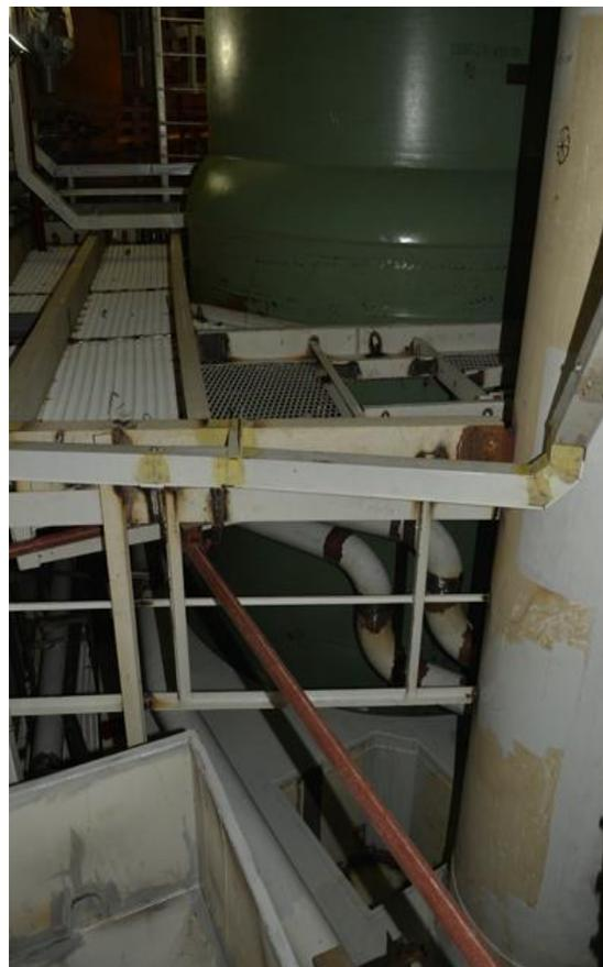
**Установка последней, четвертой, гидроёмкости аварийного охлаждения активной зоны реактора (ГЕ САОЗ) энергоблока №4 Ростовской АЭС .**
