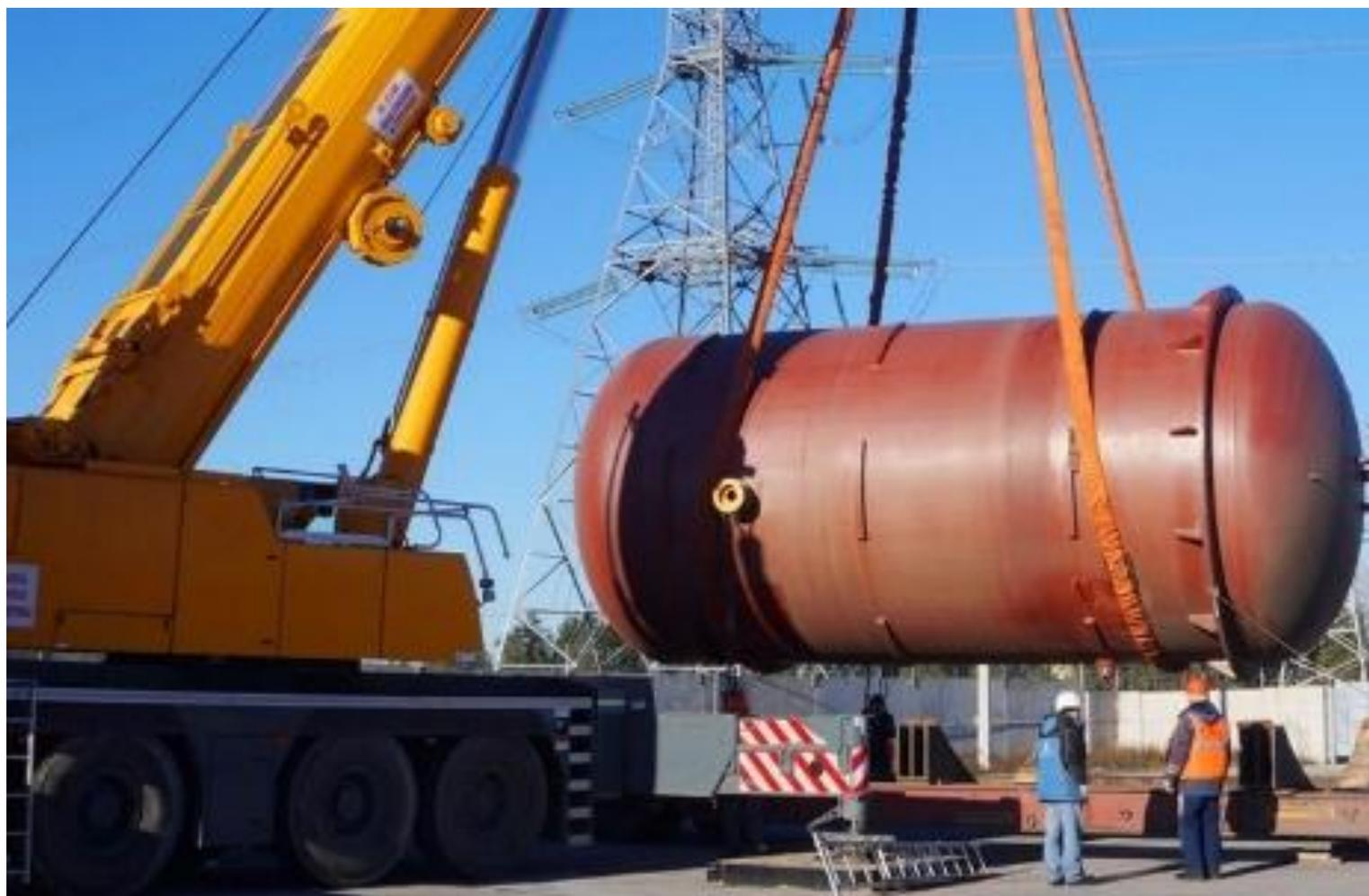
На площадку тяжеловесов Нововоронежской АЭС-2 доставлены две первые емкости системы пассивного залива активной зоны (СПЗАЗ) для второго энергоблока.
