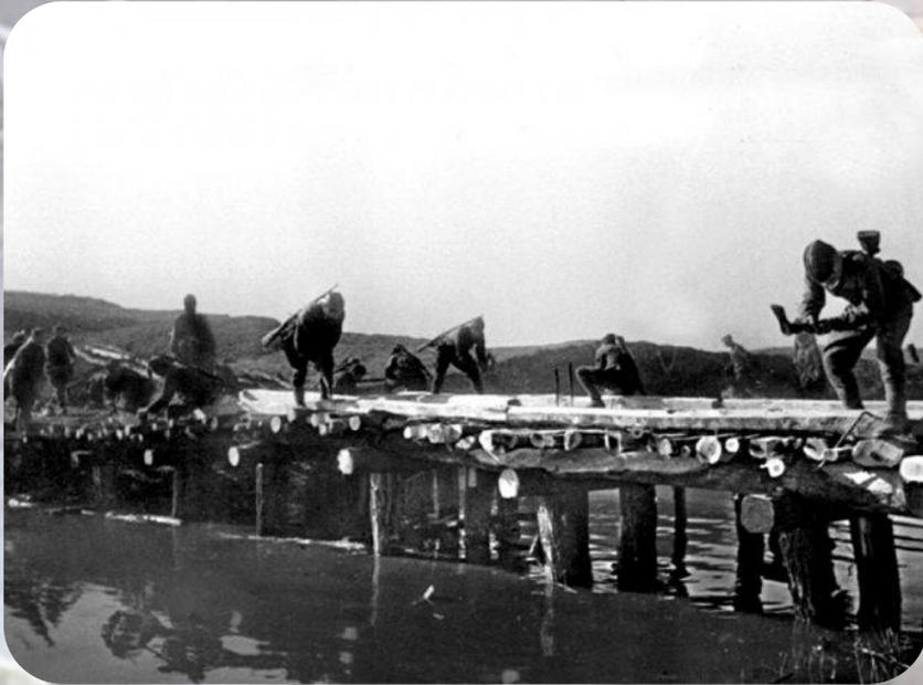
Сопровождая наступление 2 стрелкового батальона, тов Киселев в селе Яблонки обнаружил минное поле противника у взорванного моста и сам лично снял 169 противопехотных мин, затем мобилизовал гражданское население и обеспечил объезд взорванного моста, устроив деревянный настил через реку.
