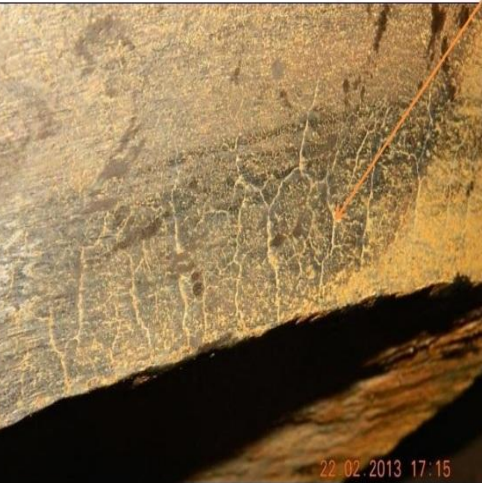
Сетка трещин
