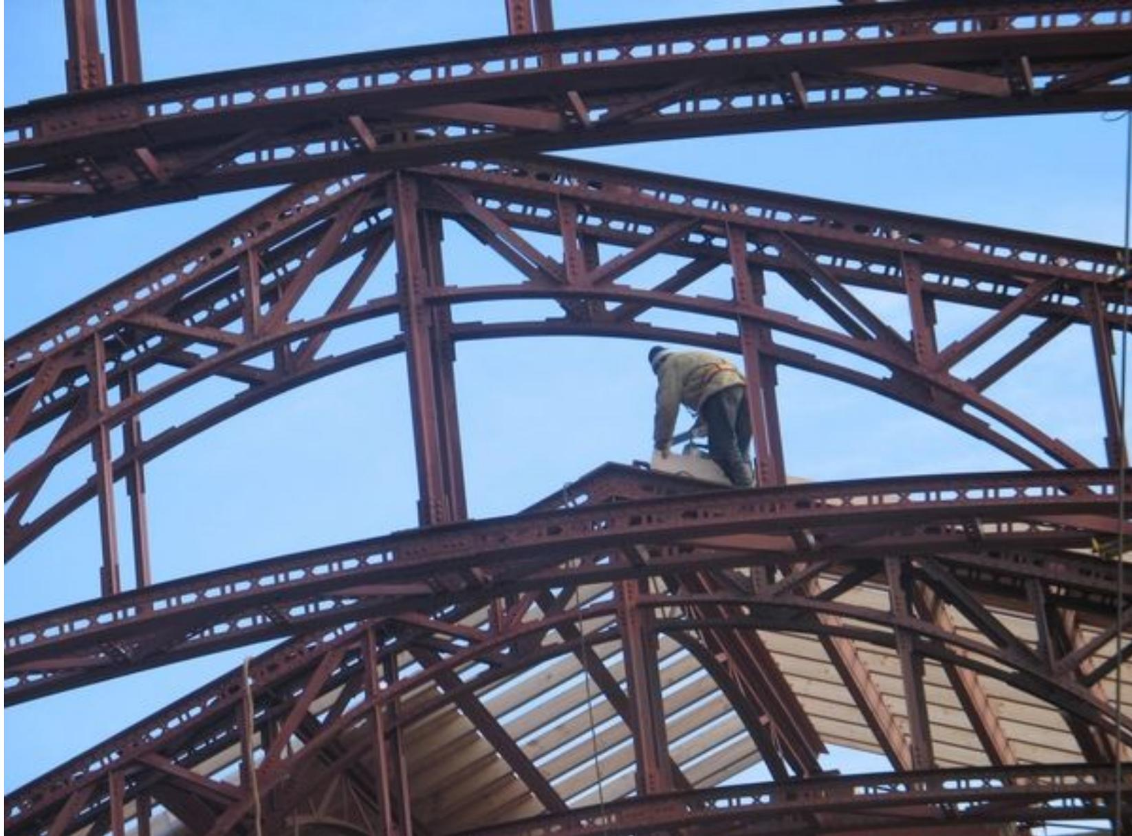
Монтаж клёпанных конструкций перекрытия конного манежа
