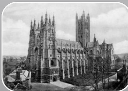
Строительство общественных сооружений
