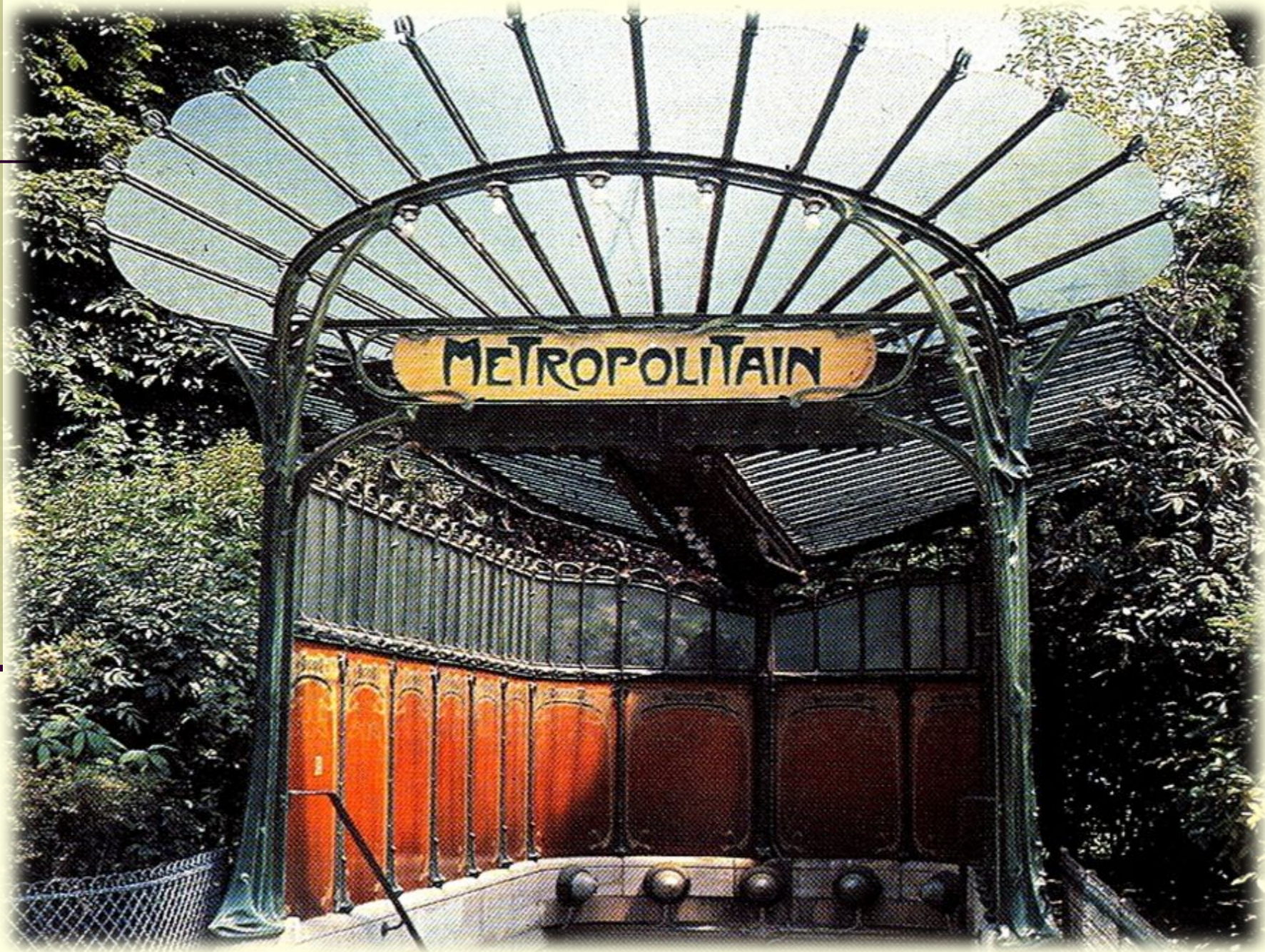
станция метро в Париже, около 1900 г.
