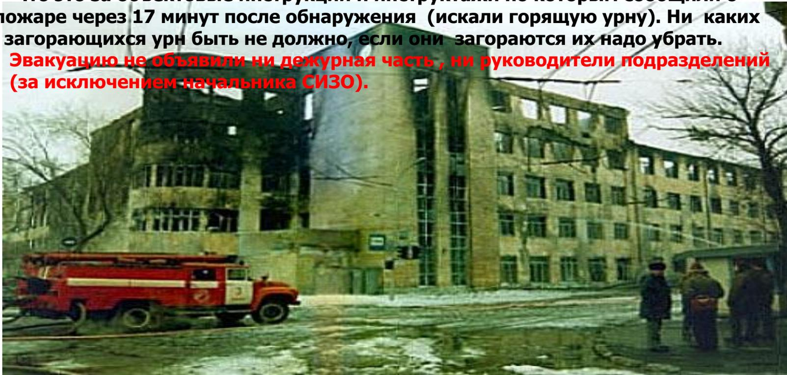
Положение усугубили сняв в центральной лестничной клетке все поэтажные двери...(п.36г...) и закрыв на замки другую л/к ( п.35...) На стенах коридоров и центральной лестницы разместили горючие материалы (в виде стендов). **Деревянные пустотные перекрытия и перегородки выгорели, от здания остался один остов.**
