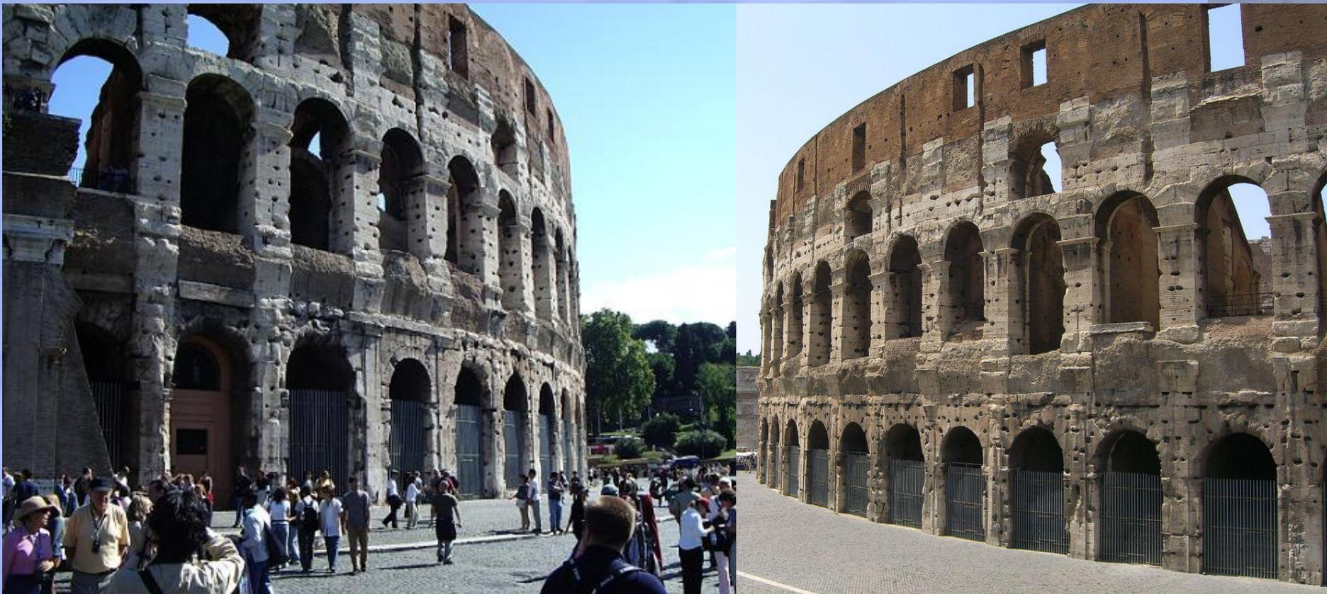
В средние века Колизей стал чем-то вроде гигантской каменоломни. Были сняты блоки травертина. До сих пор видны отверстия от металлических скреп, соединявших блоки.
