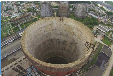
Обследование кирпичной трубы Заказчик: Филиал РУП "Минскэнерго" "Минская ТЭЦ-3" Плановые сроки: 30 дней
