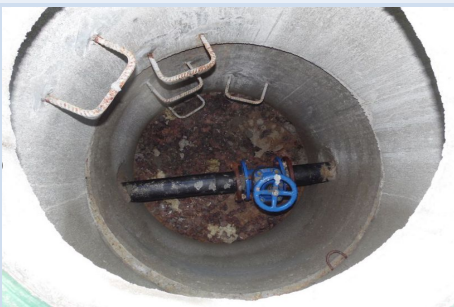
Обследование сетей водоснабжения Заказчик: Белорусский протезно-ортопедический восстановительный центр Плановые сроки: 20 дней
