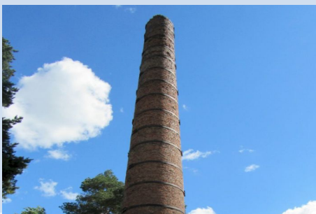
Обследование кирпичной трубы Заказчик: УП "Коммунальник" Плановые сроки: 25 дней
