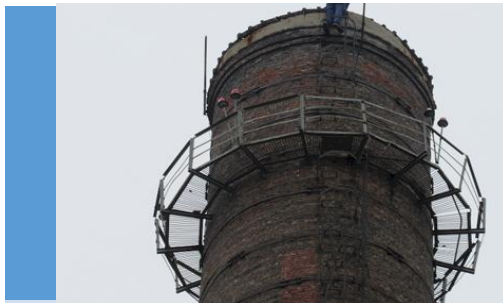
Обследование кирпичной трубы Заказчик: ОАО "Керамин" Плановые сроки: 25 дней
