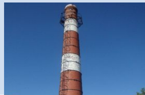
Обследование кирпичной трубы Заказчик: ОАО "Столбцовский мясоконсервный комбинат" Плановые сроки: 25 дней
