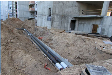
Обследование сетей водоснабжения Заказчик: ООО "Жилстройкомплект" Плановые сроки: 20 дней
