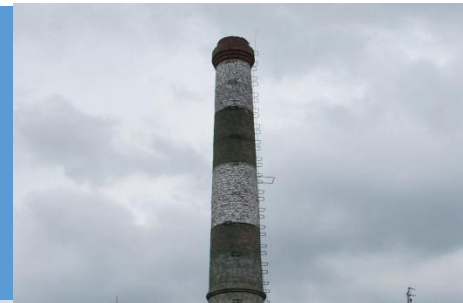
Обследование кирпичной трубы Заказчик: УП "Волковысское коммунальное хозяйство" Плановые сроки: 30 дней
