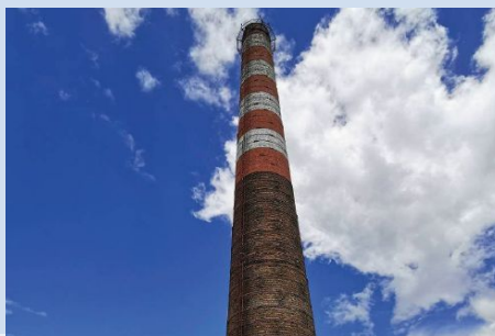
Обследование кирпичной трубы Заказчик: ОАО "Слуцкий мясокомбинат" Плановые сроки: 35 дней
