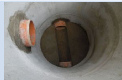
Обследование сетей водоснабжения Заказчик: Белорусский протезно- ортопедический восстановительный центр Плановые сроки: 15 дней
