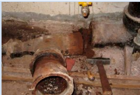
Обследование сетей водоснабжения Заказчик: ГП "Белгипродор" Плановые сроки: 25 дней
