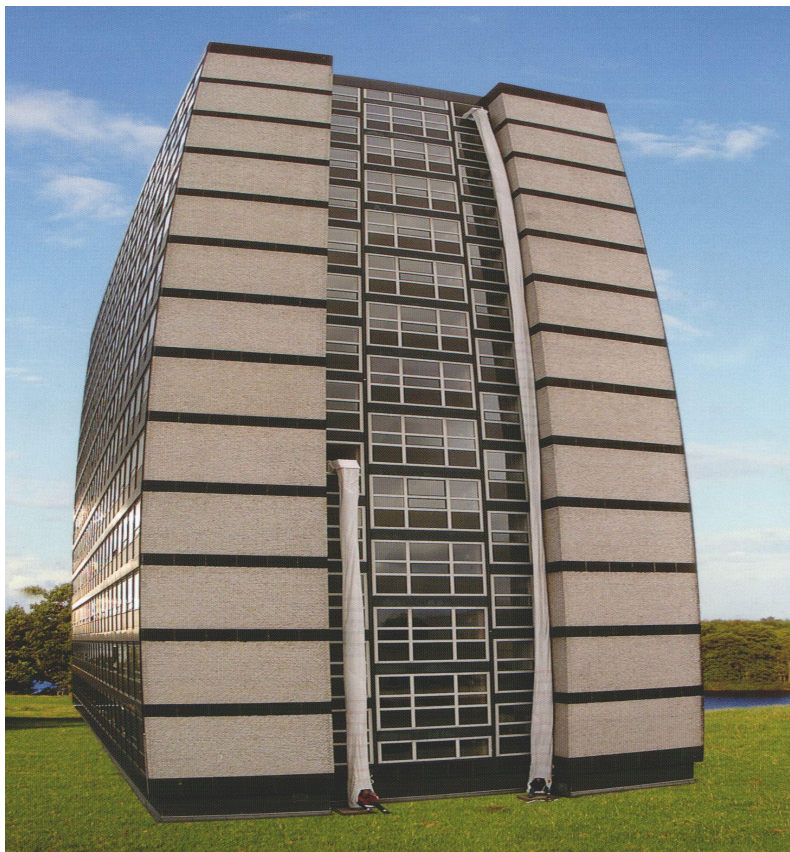
Здание оборудованное спиральным спасательным рукавом
