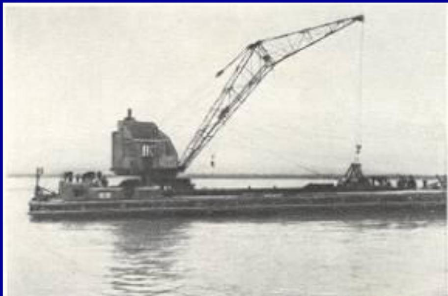
*Таковыми были краны в 30-е годы...(паровой плавучий кран грузоподъемностью 1,5 т постройки пермского завода «Старый бурлак»).*
