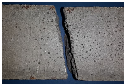
Рисунок 3 – Разрушение неармированного образца
