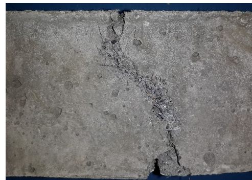
Рисунок 4 – Разрушение фибробетонного образца
