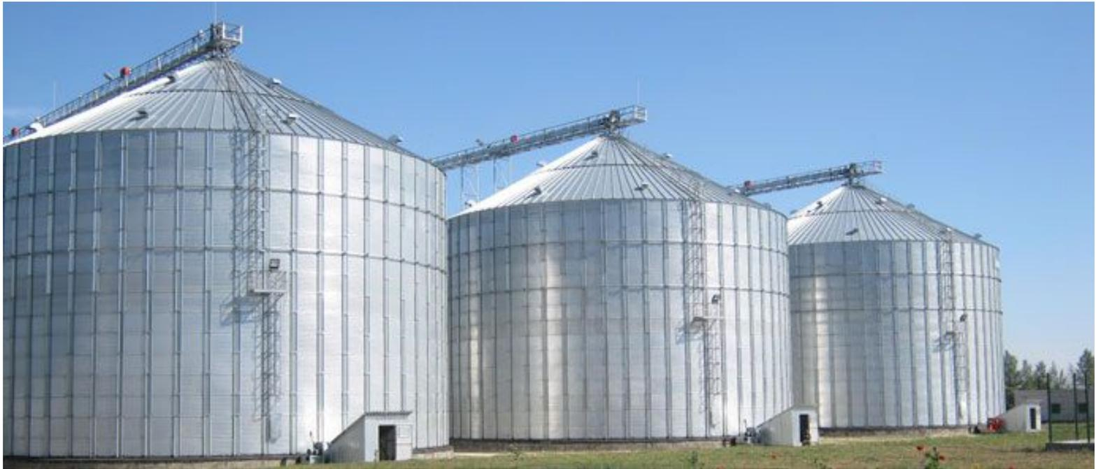
Строительство элеватора силосного типа на 50 000 тонн -первая очередь элеваторного комплекса общей емкостью 100 000 тонн для хранения зерновых и масличных культур и предприятий переработки.
