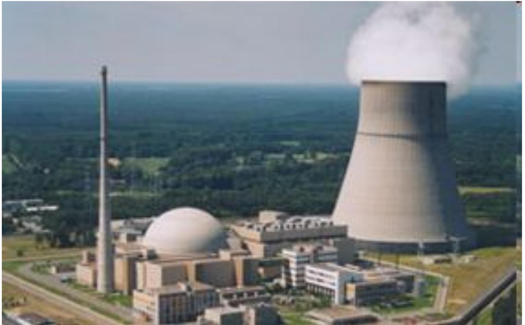
**АЭС не имеют выбросов дымовых газов и не имеют отходов в виде золы и шлаков. Однако удельные тепловыделения в охлаждающую воду у АЭС больше, чем у ТЭС, вследствие большего удельного расхода пара, а следовательно, и больших удельных расходов охлаждающей воды. Поэтому на большинстве новых АЭС предусматривается установка градирен, в которых теплота от охлаждающей воды отводится в атмосферу.**
