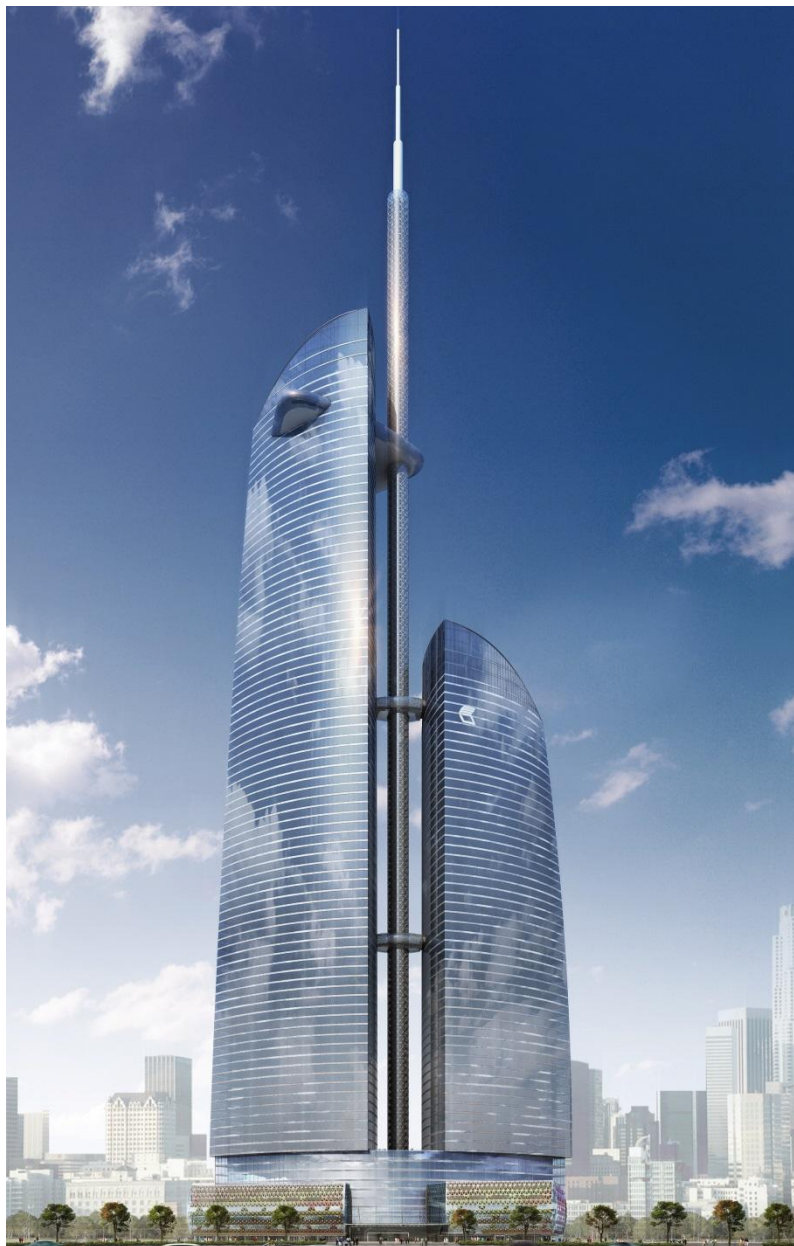
Башня Федерация, Москва
