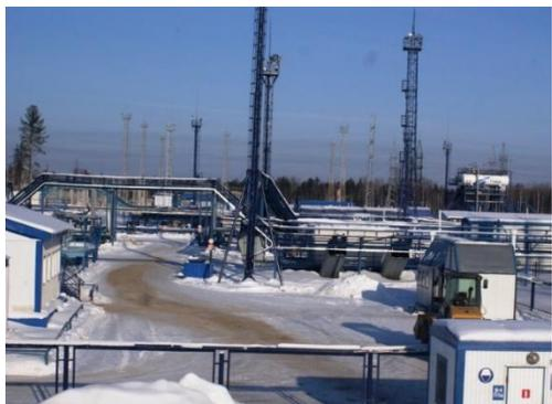
Комплексное энергоснабжение, включая обслуживание теплоэнергетического оборудования, сетей тепло- и водоснабжения Чатылькинского, Холмистого и Равнинного м/р - 34 МВт ГПЭС Waukesha, Caterpillar, ДЭС Cummins
