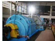
Детали и оборудование.
