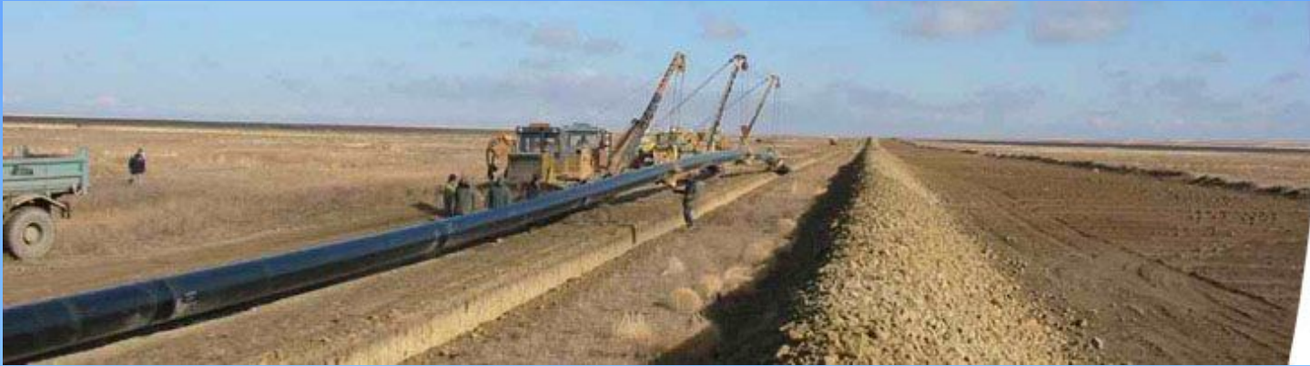
Укладка нефтепровода.
