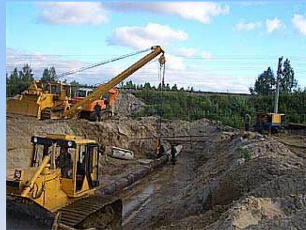
Укладка нефтепровода.
