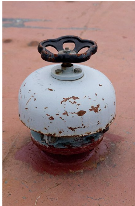
Выход вентиляционной шахты трюма на верхнюю палубу
