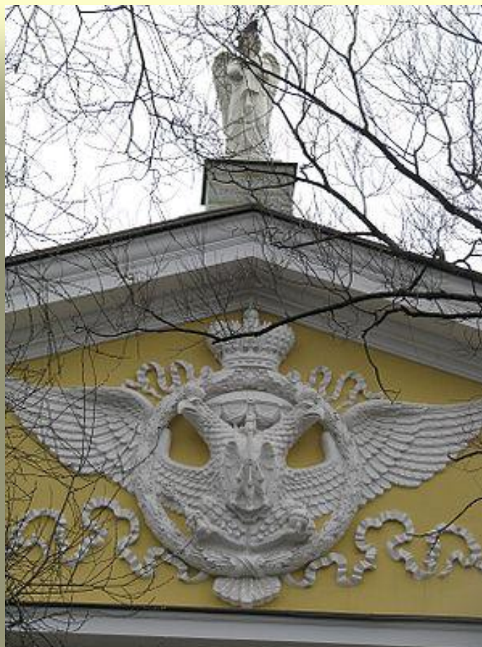
Д.Кваренги. Конек крыши главного корпуса больницы
