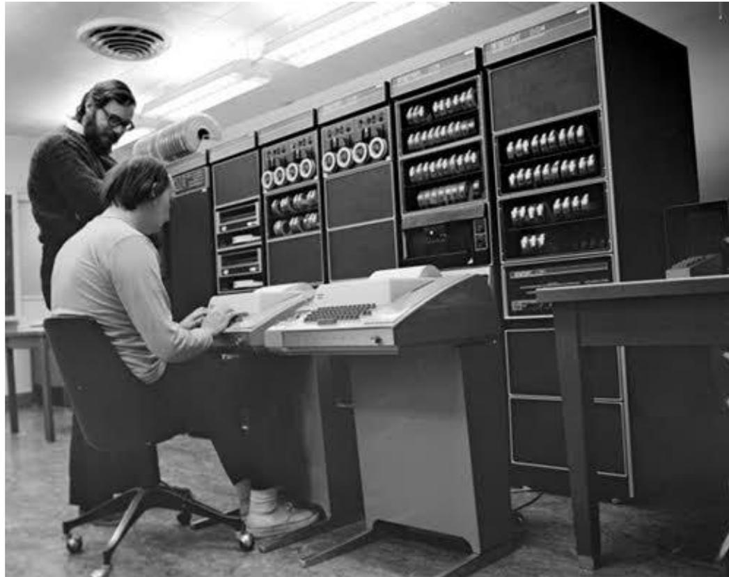
Вместе с Деннисом Ричи (на фото слева), создавшим язык С, они перенесли Unix на ЭВМ PDP-11 с двумя телетайпами в качестве терминалов (1971-1973 годы)
