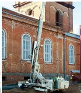
1. Цементация (микроцементация) основания:
