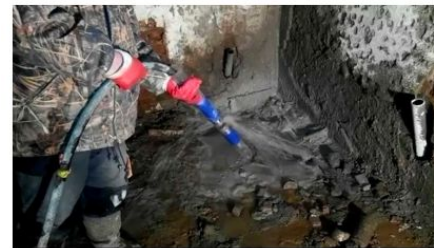
Пробные испытания пакера перед началом работы
