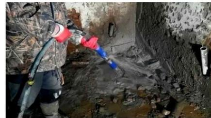
Пробные испытания пакера перед началом работы
