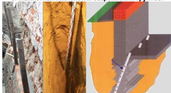
3. Манжетная технология закрепления грунтов:
